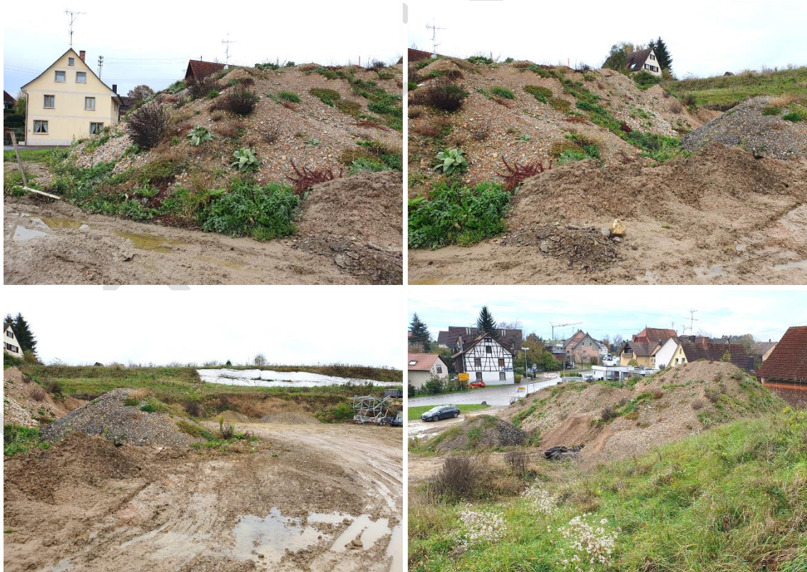
Abbildung 27: Die Haufwerke aus Baustoffrecyclingmaterial im Plangebiet, Stand: 09.11. 2022
